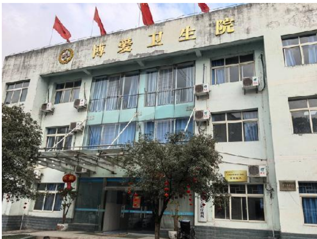
图 3-3 门诊住院综合楼
